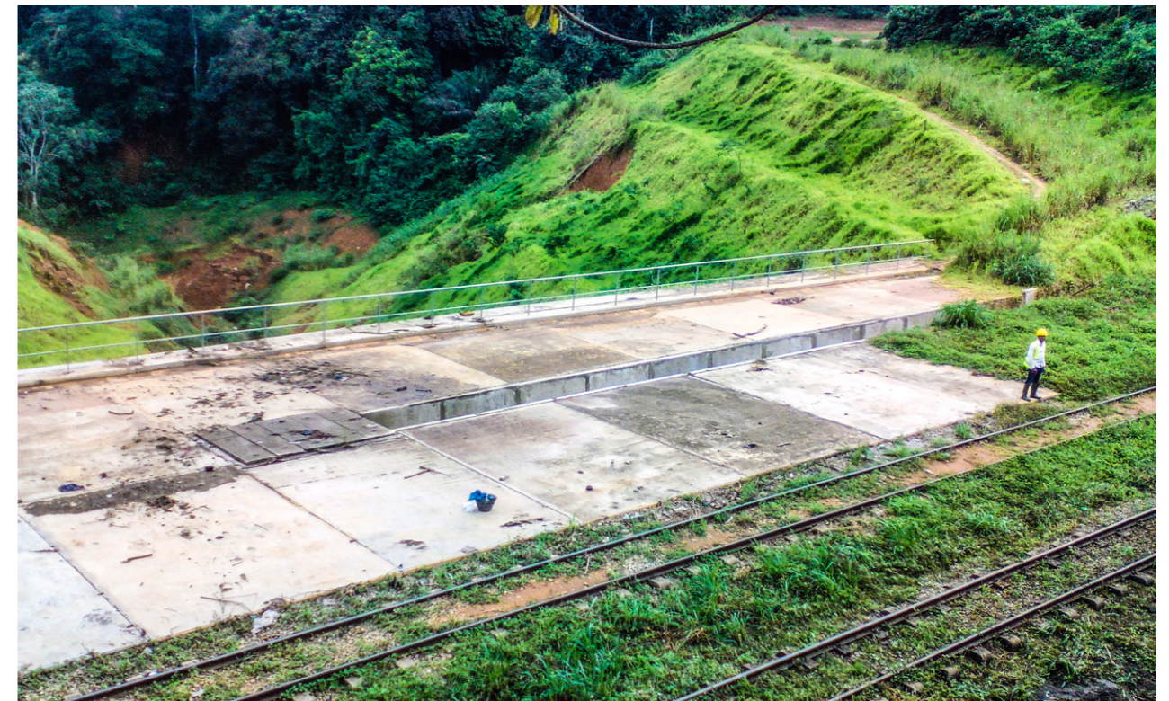
Panoramique de l'ouvrage réalisé par la SITARAIL en 2015 ©SITARAIL
