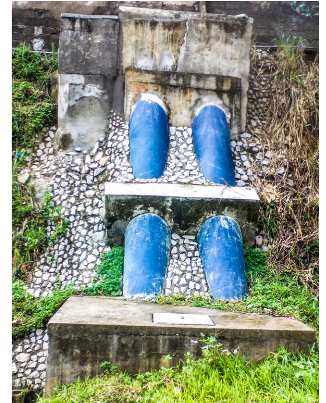
Vue d'ensemble de l'ouvrage réalisé par FILTISAC un an après - ©FILTISAC
